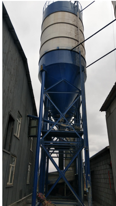
原料储罐装置
