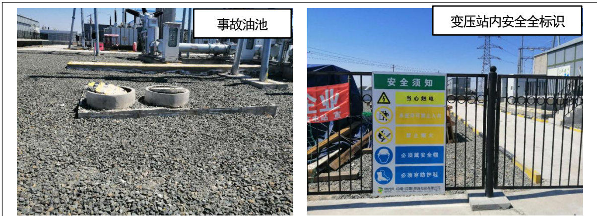
图 4-1 升压站站內新建设备设施现状（调查期 2020 年 4 月）
