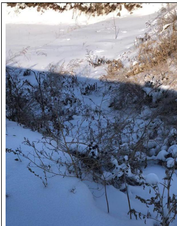
原有的废水储存池回填前
